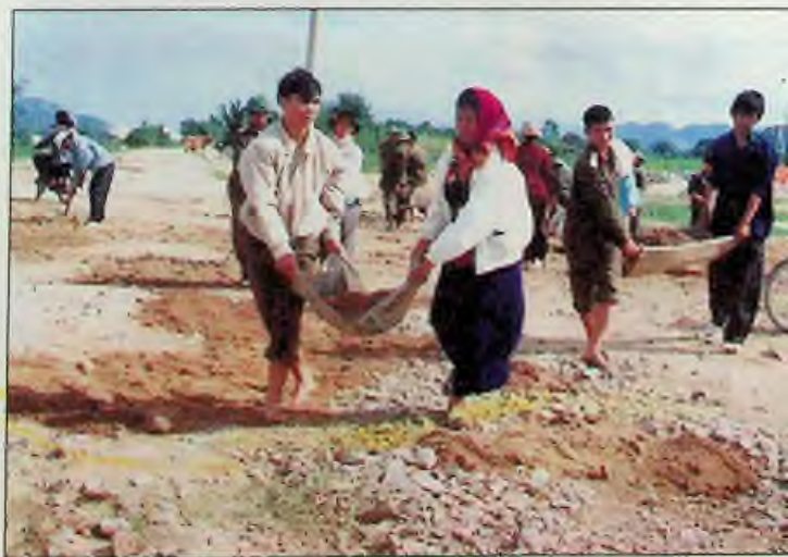
Cùng với nhân dân khác phục, sửa chữa đường giao thông nông thôn.
