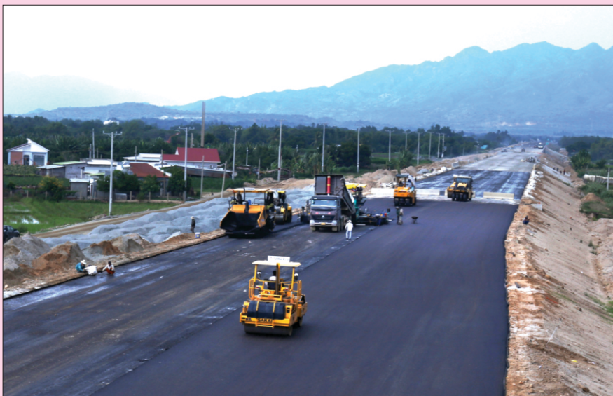
Đẩy nhanh tiến độ xây dựng tuyến đường cao tốc đoạn qua tỉnh Ninh Thuận.
